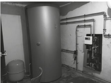
„Der neue Brauchwasserspeicher und das Frischwassermodul sind installiert“
