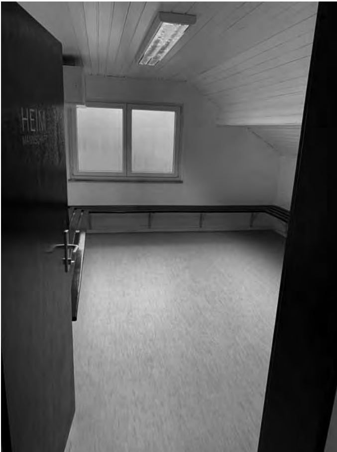
renovierte Umkleiden der SPVGG
