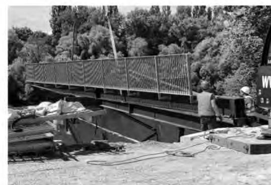
Auf der Höhe der Thermen entsteht ein neuer Aussichtssteg am Rhein. Letzte Woche wurde die Stahlkonstruktion in die Fundamente eingehoben. Die Holzbeplankung wird voraussichtlich Anfang September folgen.
